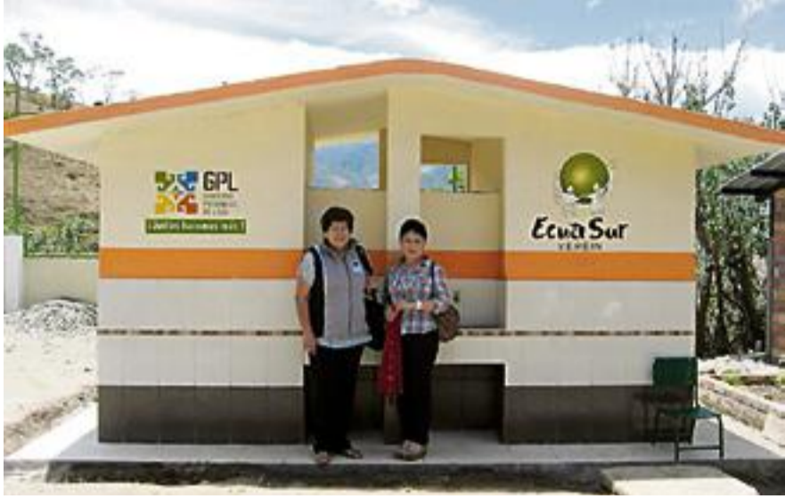
Maira Palacios und Alicia Jacome von Ecuasur mit den neuen sanitären Anlagen in der Schule Bellamaria.
